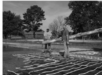
POUR AND FINISH CONCRETE
