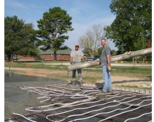
POUR AND FINISH CONCRETE
